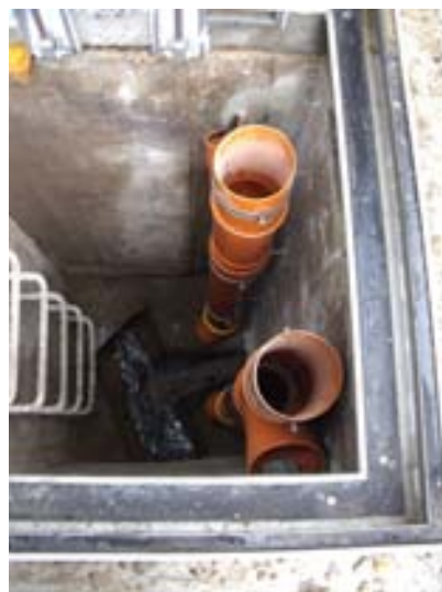
Aansluiting retourleiding op bestaande put
